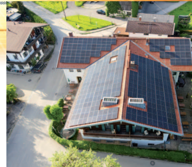
Die Anlage auf dem Gebäude vom Gasthof „Hinterwirt“ in Übersee. Foto: Trummer
