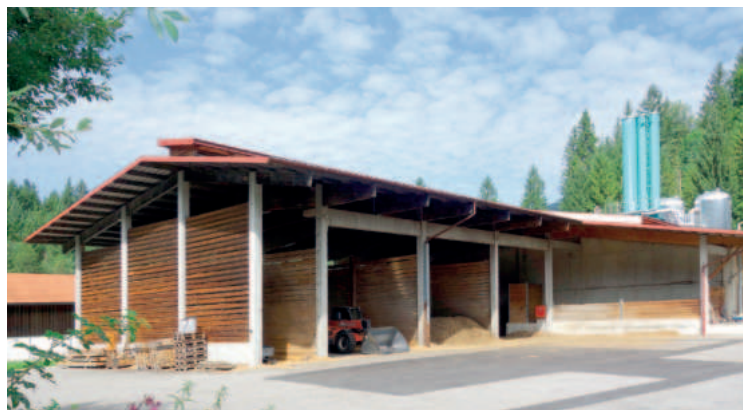
Den Beteiligungsbericht 2022 an der Naturwärme Reit im Winkl stellte der Gemeinderat in seiner Sitzung fest. Unser Bild zeigt das Biomasse-Heizwerk an der Tiroler Straße. Foto: Hauser
